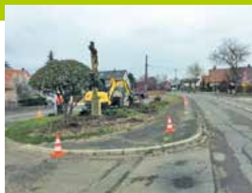
Rue des étourneaux avant
