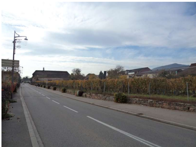
Route de Wettolsheim
